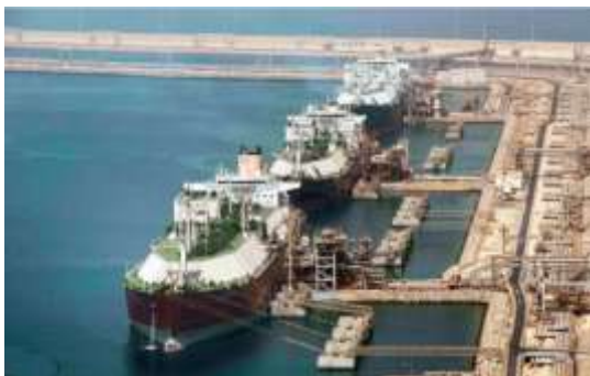
Qatargas's Ras Laffan LNG Terminal (Upstream) One of World's Largest LNG Loading Terminals
